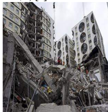
Рисунок 1. Шкала Ріхтера та приклад руйнувань через землетрус а) шкала Ріхтера; б) наслідки землетрусу в Туреччині та Сирії
