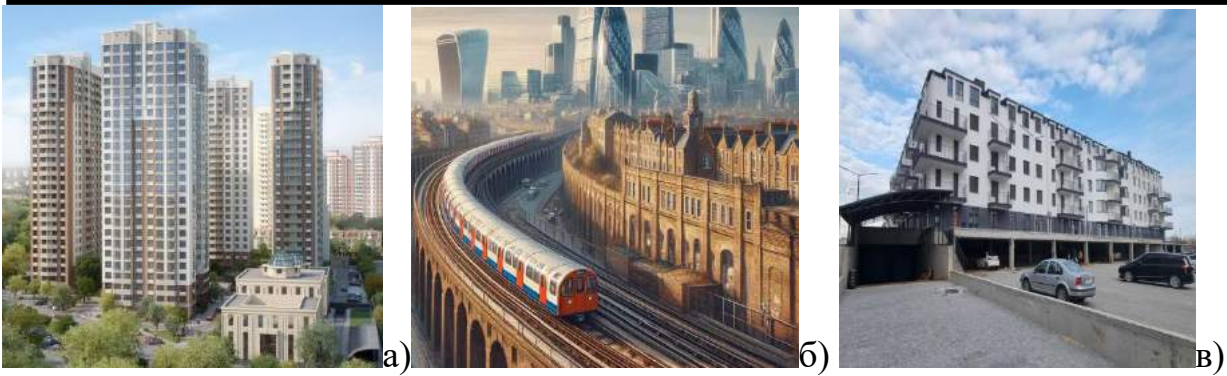
Рисунок 3. Об'єкти будівництва, обладнані системами сейсмо – та віброізоляції з використанням гумово – металевих блоків
